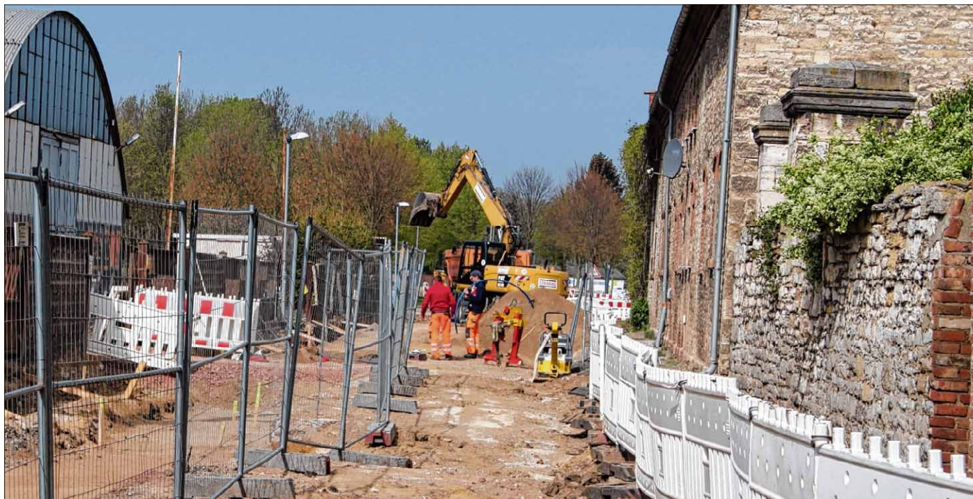
Der Breitbandausbau in der Westlichen Börde steht trotz des Verlustes der ausführenden Baufirma nicht still. So werden im Rahmen der Straßenausbauprojekte wie hier in Großalsleben Leerrohre durch die Straßenbaufirmen verlegt.
