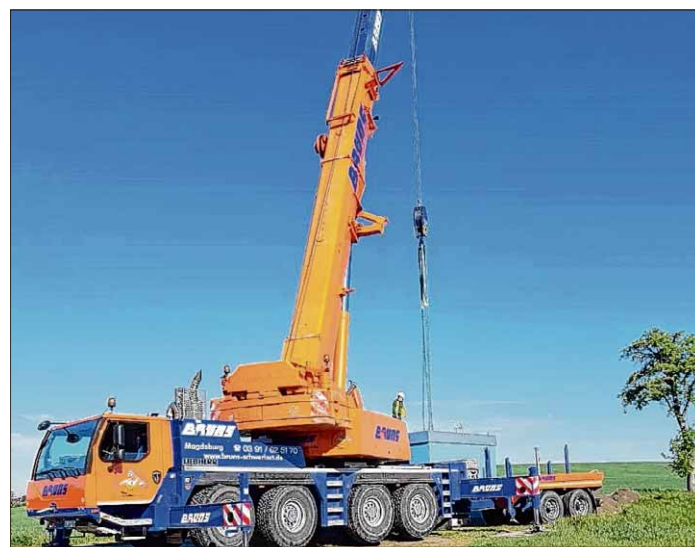
Der Kran setzt die Pop-Station in die vorbereitete Fläche am Ortsrand von Warsleben. Foto: Dietmar Schmidt
